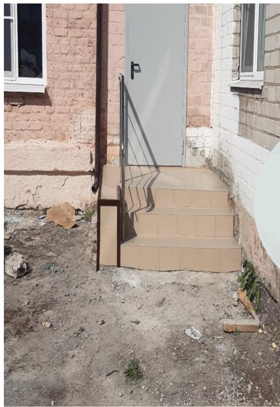
Выход (крыльцо) после реализации проекта
